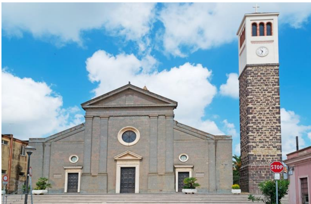
Figura 9: Facciata della Chiesa Santa Maria ( www.corsadegliscalzi.it )
