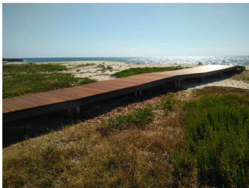
Foto.5 - Esempio di passerella per la regolamentazione del transito pedonale dell'area oggetto di tutela
