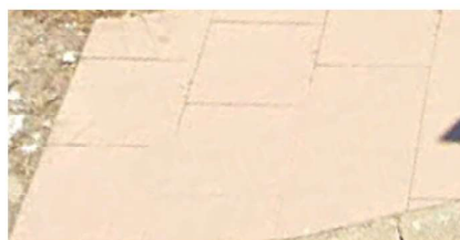
A03.3 Pavimentazione in lastre autobloccanti di calcestruzzo
