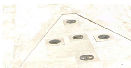
A05.1 Pavimentazione in lastre di marmo bianco
