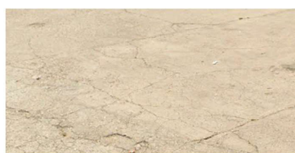
A03.1 Pavimentazione in calcestruzzo
