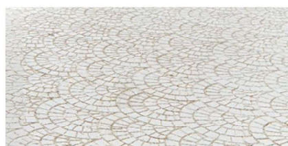
A03.5 Pavimentazione in lastre di calcestruzzo
