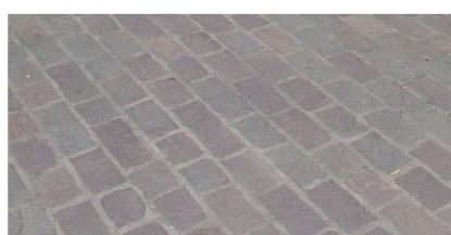
A02.3 Pavimentazione in lastre di porfido
