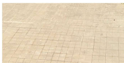
A03.6 Pavimentazione in lastre di calcestruzzo
