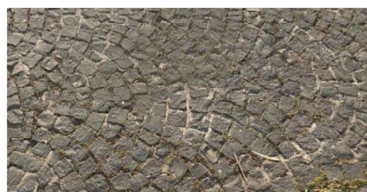
A02.1 Pavimentazione in blocchi di porfido scuro sbozzato
