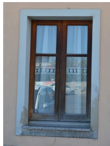
TIPOLOGIA ..... CC.02_Finestra con architrave-stipiti intonacati e tinteggiati
