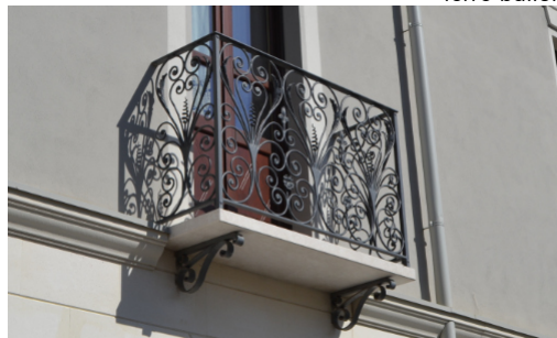
H.02 Longheroni e parapetto in ferro battuto
