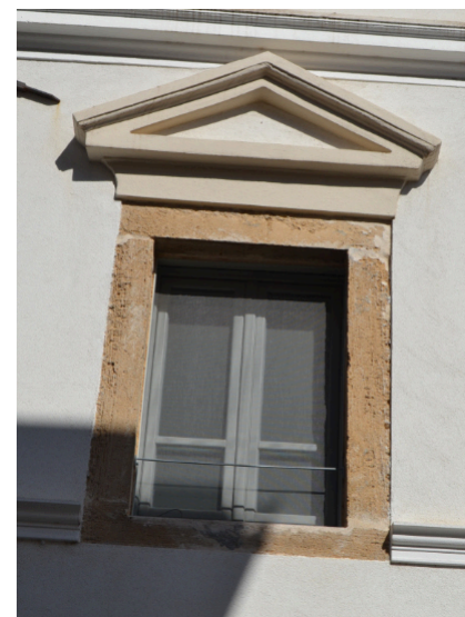
TIPOLOGIA ..... CC.05_Finestra con architrave-stipiti lapiidei e timpano
